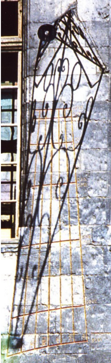
5. Détail de la méridienne en plein soleil, peu après sa restauration : les lignes horaires gravées dans le mur sont dorées, les arcs diurnes sont colorés en bordeaux. En bas à gauche, le point lumineux indique 11.35 h, vers la période du solstice d'été. (© Gnomonica)
