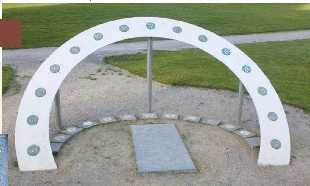
**Le cadran analemmatique est la portion posée à même le sol.** En blanc, c'est le cercle tronqué et incliné à  $39^\circ$  (complément de la latitude de Genk).
