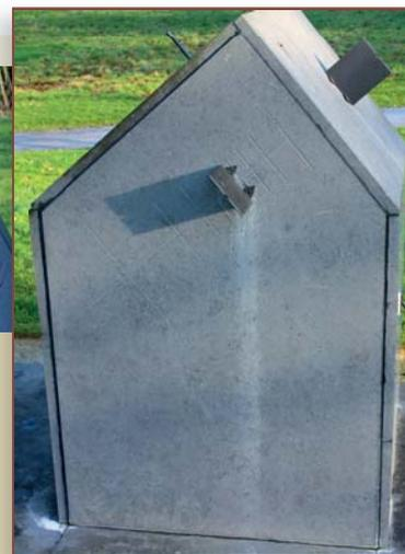
**Vue du cadran occidental du bloc gnomonique.** La plaque vue au dessus est le style du cadran polaire. La tige à gauche est le style du cadran équatorial. On remarquera qu'il est bien dans le prolongement du style du cadran méridional à droite de la photo et que ces deux style sont parallèles au bord du style du polaire. Cet ensemble est parallèle à l'axe de la Terre (l'axe des pôles).
